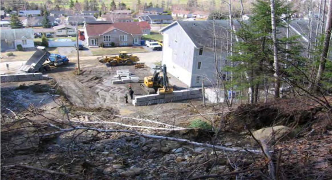
Photo 2 – Glissement de terrain survenu le 29 avril 2008 sur la rue de la Seigneurie-Ouest
